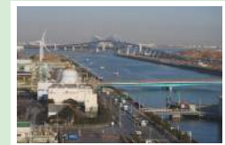
海の森水上競技場整備予定地
